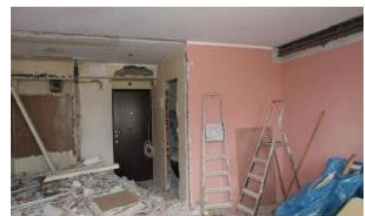
Перепланировка и ремонт
